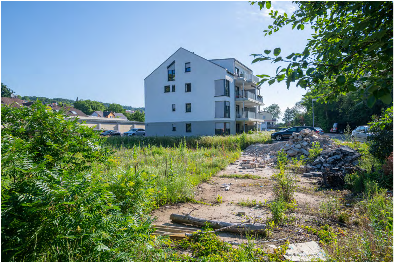
Links neben dem Rodensteinweg 2/2a entsteht der Zwilling Rodensteinweg 4/4a.
